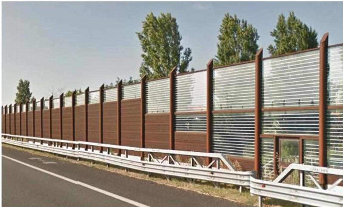
Figura 11-56. Autostrada A14 Tratto Rimini – Cattolica, barriera acustica di altezza 5 m con montanti carterati, con taglio sommitale a becco di flauto, e pannellature trasparenti con striature anticollisione per l'avifauna
