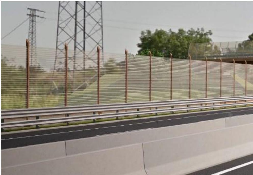
*Figura 12-38: Esempio di barriera acustica trasparente prevista nel progetto a seguito delle integrazioni di V.I.A. con taglio sommitale a becco di flauto ed eliminazione della cornice sommitale al pannello trasparente più alto.*
