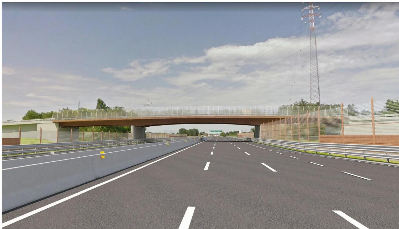
Figura 12-42: Fotoinserimento del cavalcavia di progetto "CV03" a tre luci, vista carreggiata nord. In carreggiata nord barriere acustiche h 5 m, in carreggiata sud barriere acustiche h 3 m. Per rendere simmetrico il trattamento delle due barriere e la percezione del cavalcavia si prevedono 11 campate trasparenti per entrambe i lati
